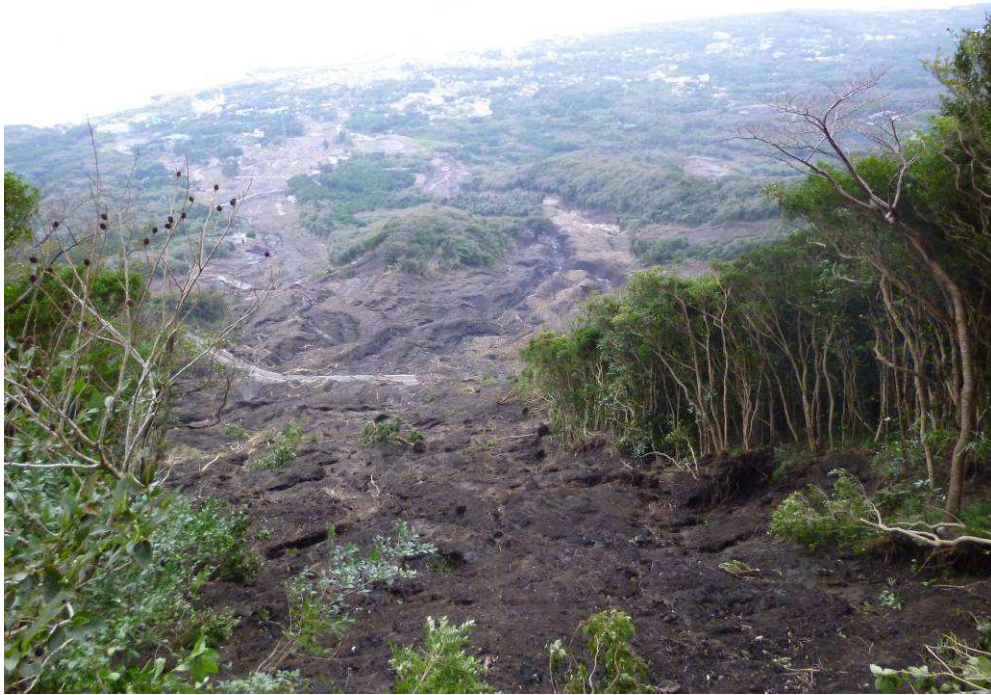
写真3：御神火スカイラインより下方の斜面崩壊。溶岩が地表に出ている。
