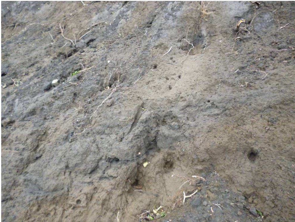
写真2：御神火スカイライン上方の崩壊斜面に見られたパイピングホール。
