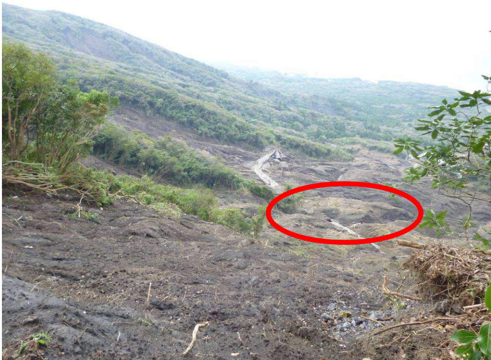
写真4：御神火スカイラインより下方の斜面崩壊。赤丸で囲ったところなどに崩落していない不安定な土砂が見られる。
