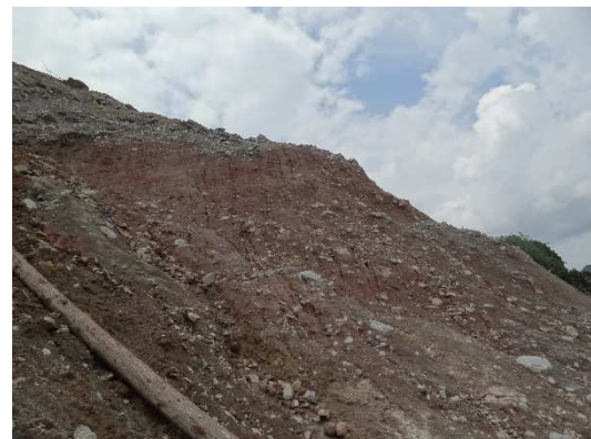
写真4：地下水が流れ出た痕跡。
