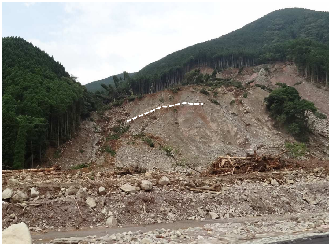
写真1：崩壊地の全景。
