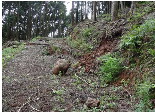
写真7：崩壊域上方の段差亀裂。
