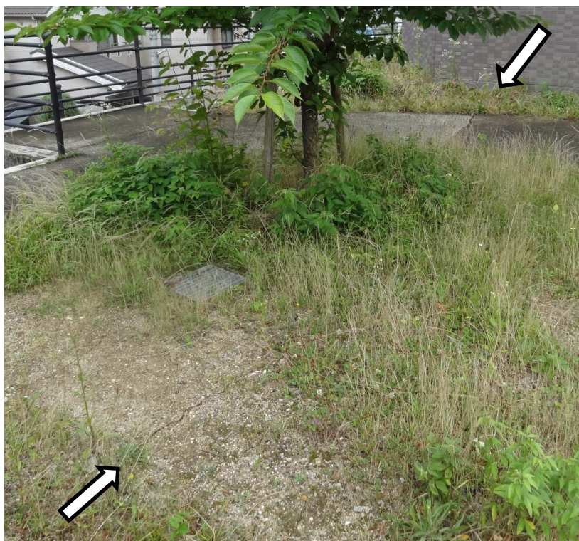
写真2：公園に隣接するマンションの敷地における開口亀裂。
