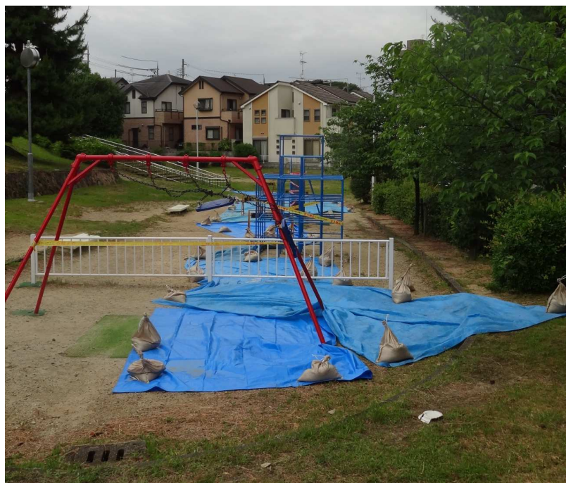
写真1：公園内の亀裂の様子。
