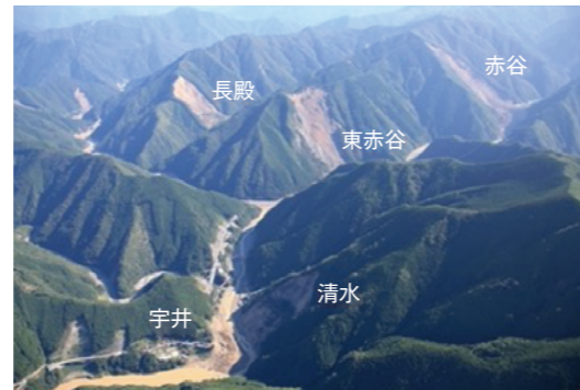
2011年台風12号に伴う豪雨により生じた地すべりと天然ダム(道窪氏撮影) Landslides and natural dams caused by torrential rainfall associated with typhoon 12, 2011 (Photo by Mr. Michikubo)
