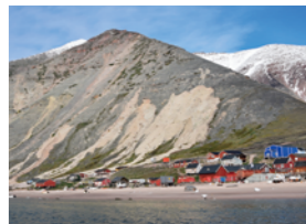
2016年に地すべり災害に見舞われたグリーンランド極北部の小集落 Small settlement in Greenland after the 2016 landslide disaster by heavy rainfall
