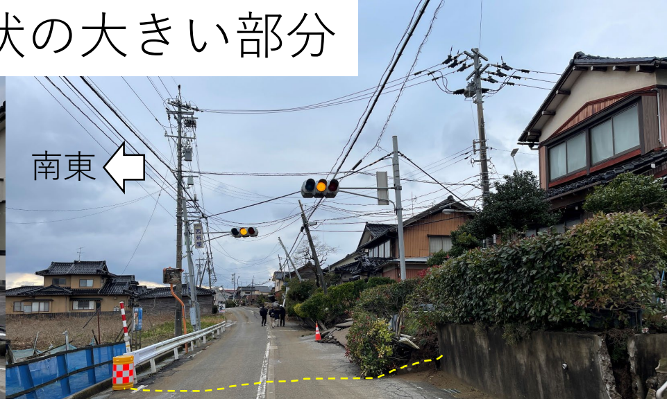
⑧：県道8号を北東から南西へ見た写真．黄色破線で示した部分より南西側（写真奥側）の路面や，宅地沿いの擁壁が大きく傾斜し，破壊されている．
