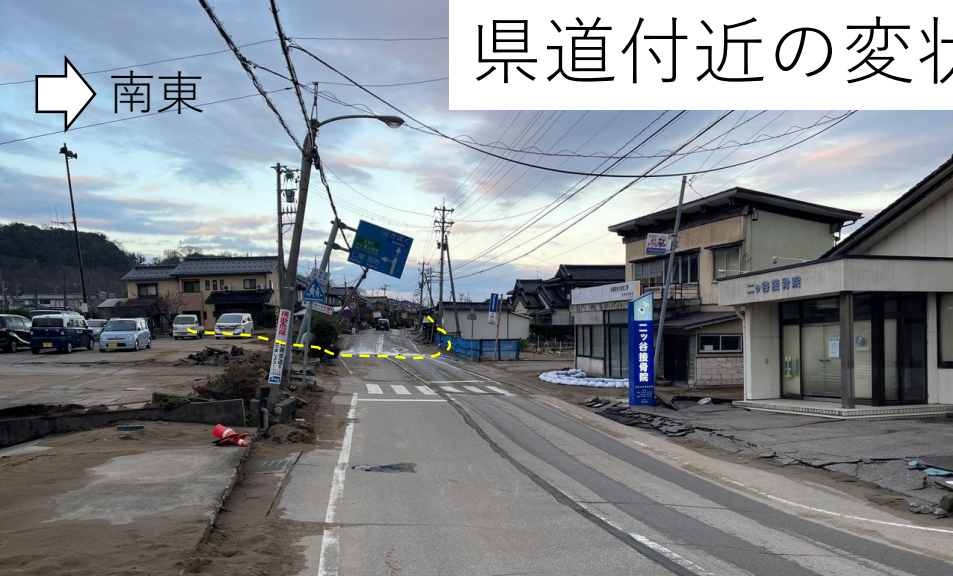
⑦：県道8号を南西から北東へ見た写真．黄色破線で示した部分より北側の路面がその南に比べて大きく高くなっている（ここでの黄色破線は前々頁航空写真の黄色破線と一致している）．
