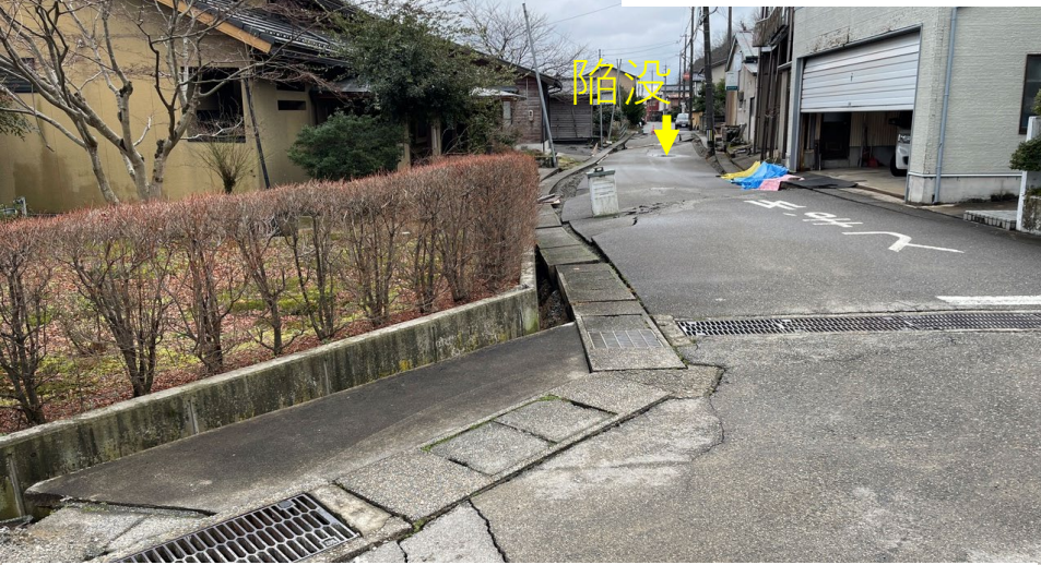
⑤：グラウンドの西側，家屋・道路付近の陥没帯．陥没のみならず路面とその境界付近に開口が形成されている．
