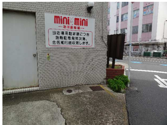
写真3：枚方市駅周辺の地盤沈下のようす。
