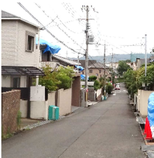
写真7：旧谷筋に相当する道路に沿うの被害の様子。
