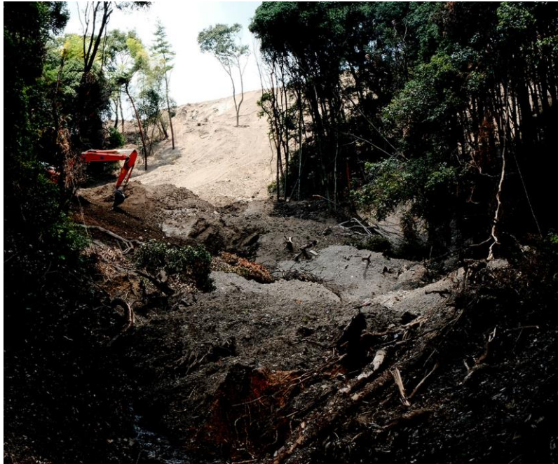
写真2 崩壊末端部の状況 (7/26)。大量の土砂が谷の上部を埋めている。ショベルカー付近と見えている斜面最上部（小段の先端、崩壊の一部）までの比高は約35m。
