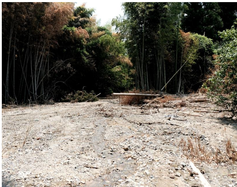
写真3 土石流末端部の状況 (7/26)。写真奥から手前に流れた大量の土砂が谷を埋めている。この付近の地表には、多くの産業廃棄物の破片が散乱している。
