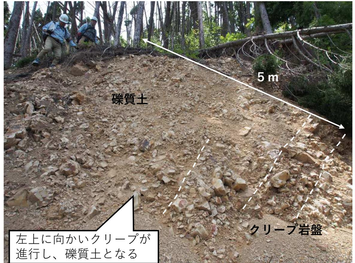
写真② 崩壊面のクリープ岩盤
