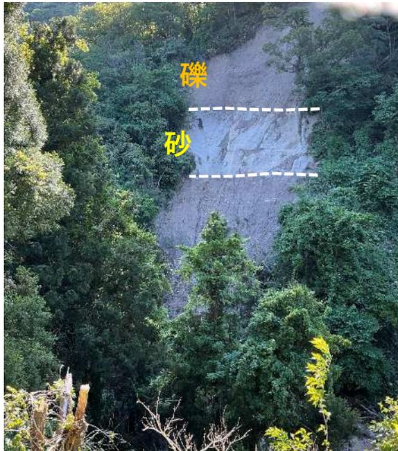
写真② 堆積岩の崩壊
