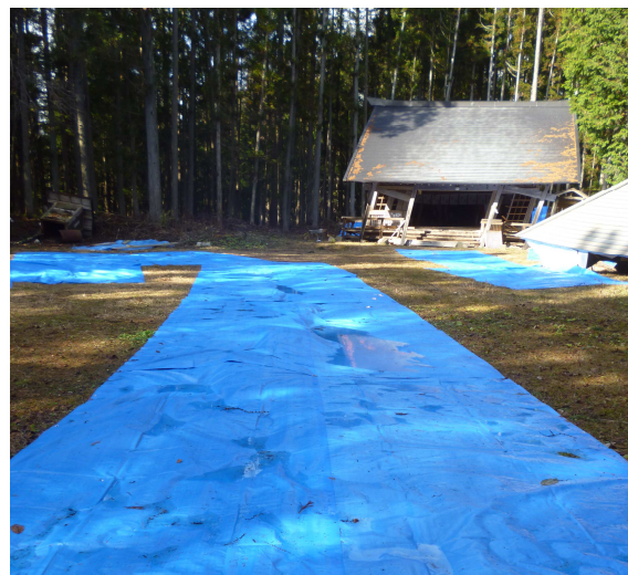
写真6：城峯神社境内の亀裂と被災した本殿
