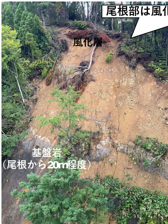
尾根付近のみが崩壊
