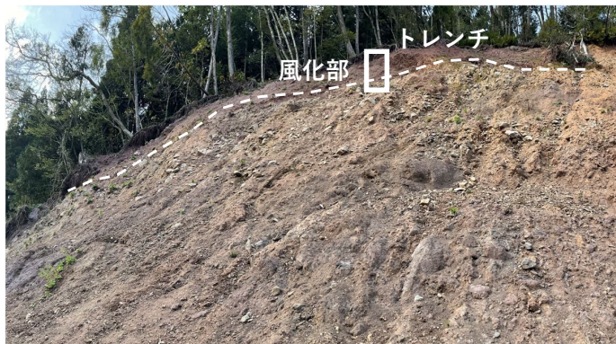
崩壊④：トレンチ作成箇所
