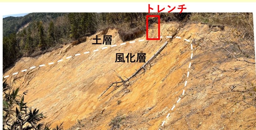
写真① 流紋岩質火砕岩の表層崩壊
