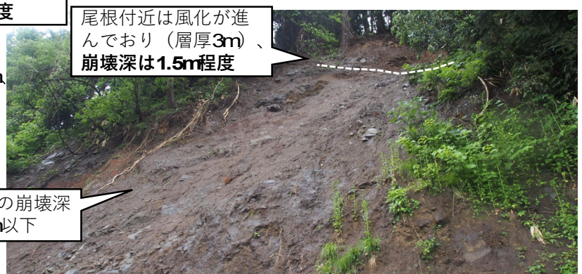
崩壊③：崩壊高さ23m、傾斜45°
