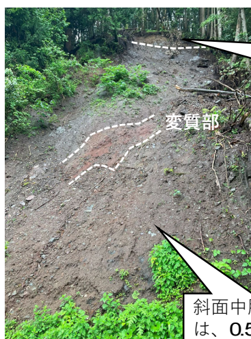
崩壊②：崩壊高さ27m、傾斜47°
